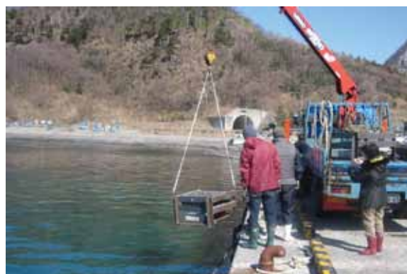
▲増殖施設の沈設作業
