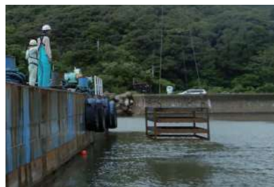
試験礁の設置
