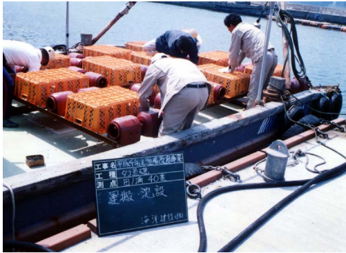
写真8 マダコ魚礁組立状況
